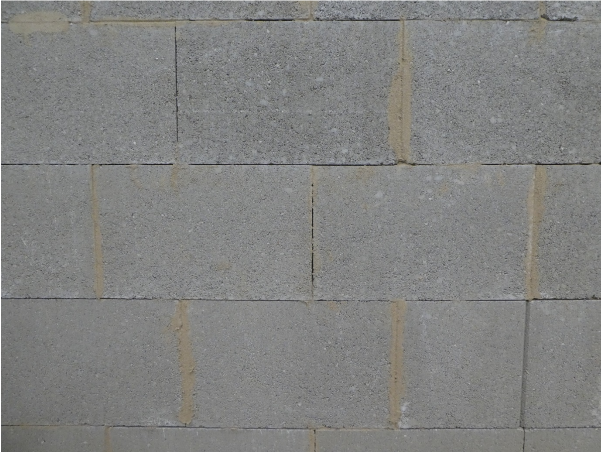
Illustration 6: Aspect de l'appareillage de la cloison, objet n° 1 soumis aux essais
