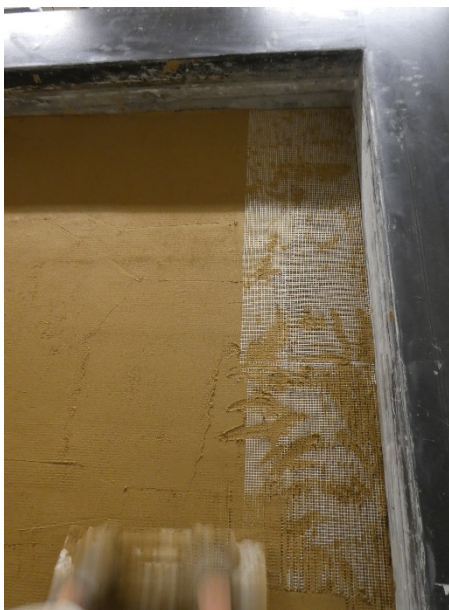
Illustration 8: Application de l'enduit à l'argile
