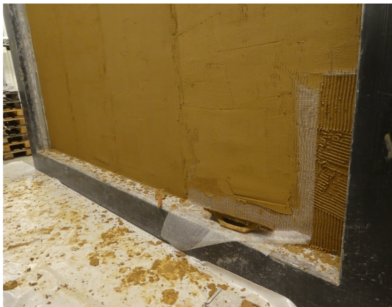
Illustration 9: Couche de 5 mm d'enduit à l'argile et son filet
