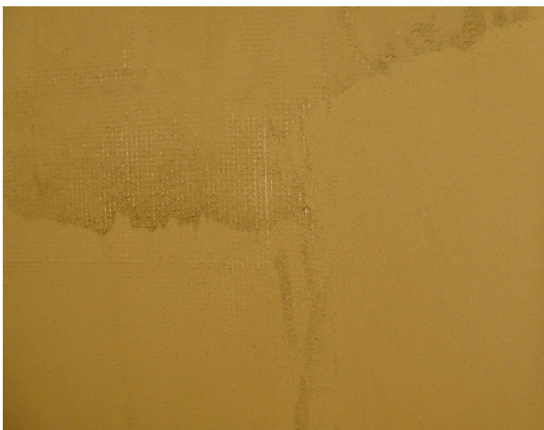
Illustration 10: Surface de la cloison TERRAPLAC garnie de 5 mm d'enduit à l'argile
