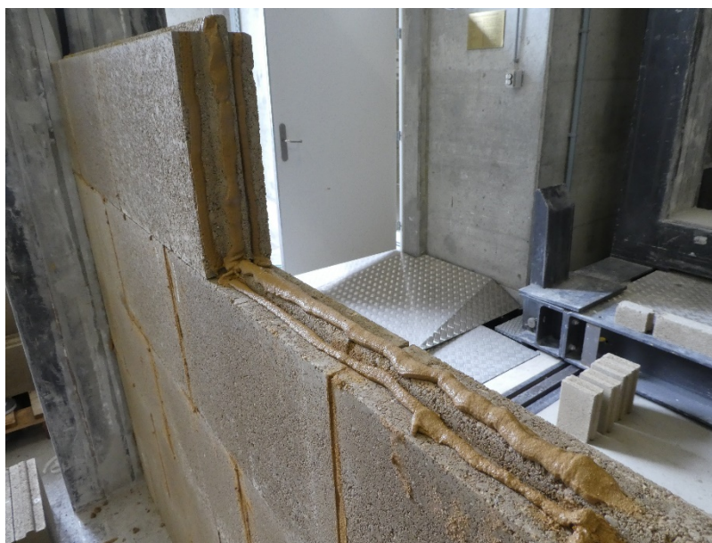
Illustration 3: Montage de la paroi TERRAPLAC à l'aide de mortier d'encollage à l'argile
