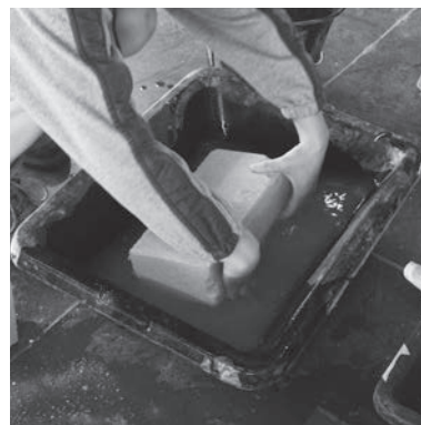
3. Tremper les BTC stabilisés ou mouiller à la brosse large en aspergeant les BTC non stabilisés
