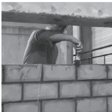
1. Humidifier le plan de pose
