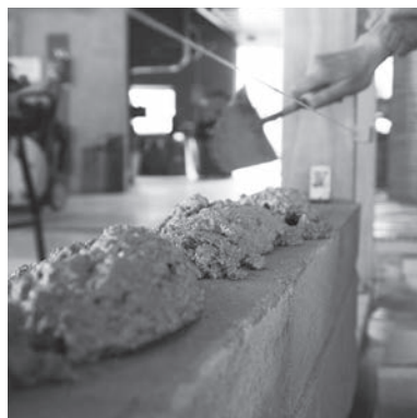
2. Disposer la juste quantité de mortier
