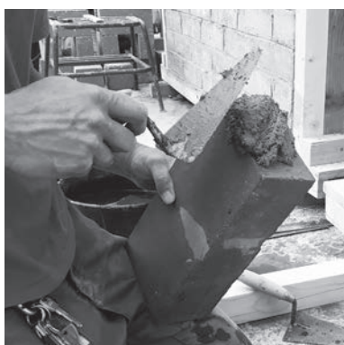
4. Appliquer le mortier sur l'extrémité du BTC ou sur la face verticale du BTC précédent
