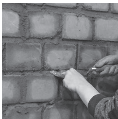
8. Tracer proprement les joints quand le mortier est encore frais et malléable
