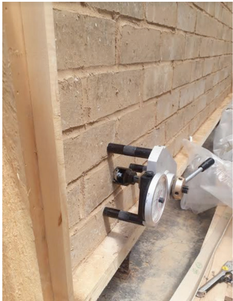
→ Mesures d'arrachement à l'extractomètre réalisées sur un mur en BTC Cycle Terre
