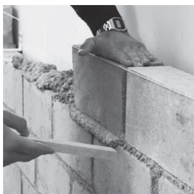
7. Retirer l'excès de mortier immédiatement
