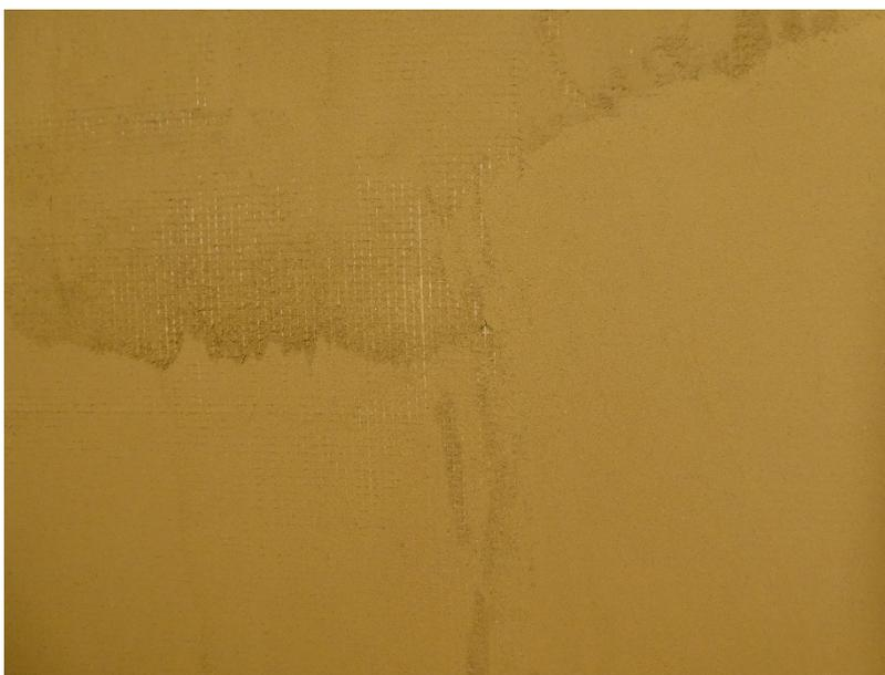
Abbildung 10: Oberfläche der TERRAPLAC Wand mit einer 5 mm Lehmputzschicht
