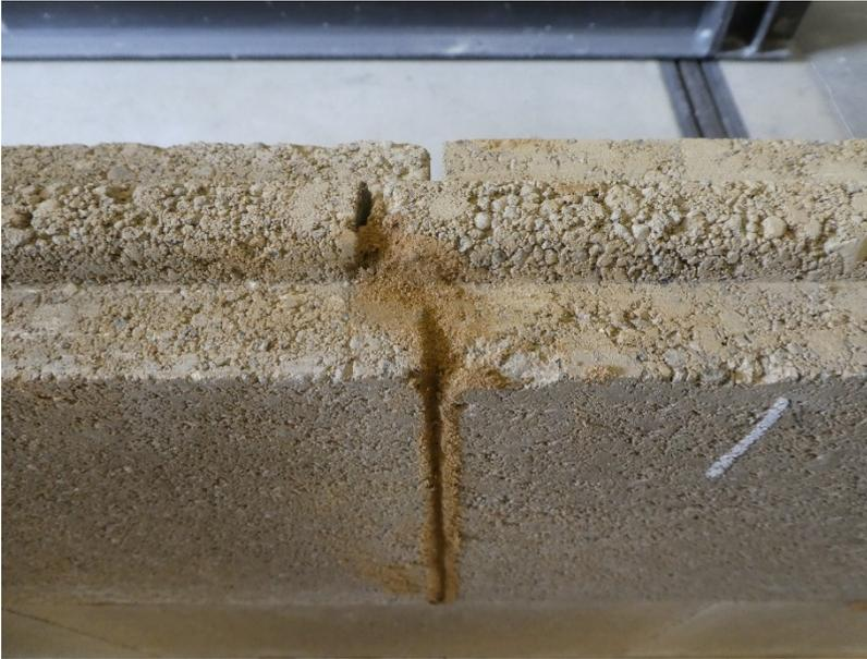
Abbildung 4: Detailansicht Fuge zwischen den einzelnen Mauersteinen
