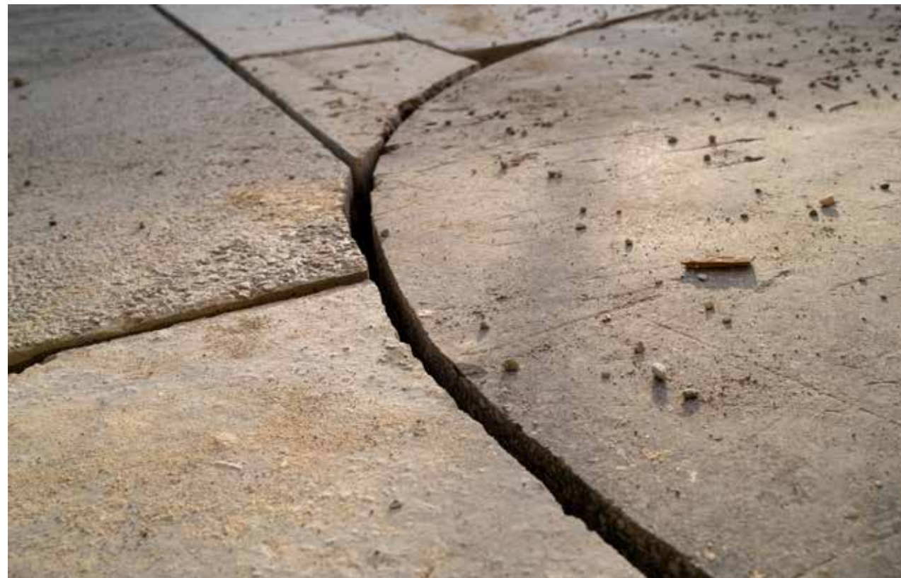
Dallage de réemploi au stade des Arbères à Meyrin par FAZ architectes Wiederverwendete Bodenplatte im Stade des Arbères in Meyrin von FAZ architectes
