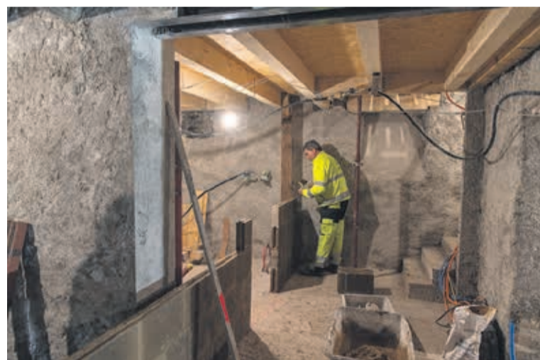
Au début du mois de février, ces nouvelles cloisons sont utilisées pour la première fois sur un chantier.
