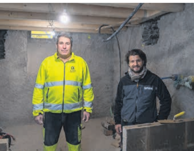
Le maçon Alberto Dos Santos et l'ingénieur Rodrigo Fernandez, un des cofondateurs de Terrabloc.
