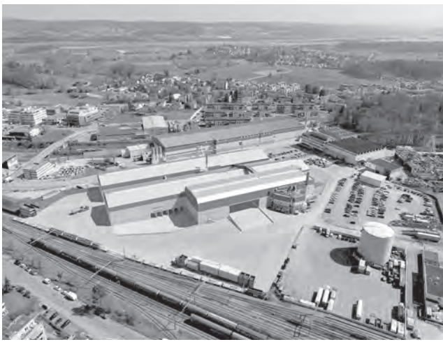
Eberhard baut in Oberglatt eine neue Aufbereitungsanlage. | Eberhard construit à Oberglatt une nouvelle installation de traitement. Renderings | Rendus: Eberhard
