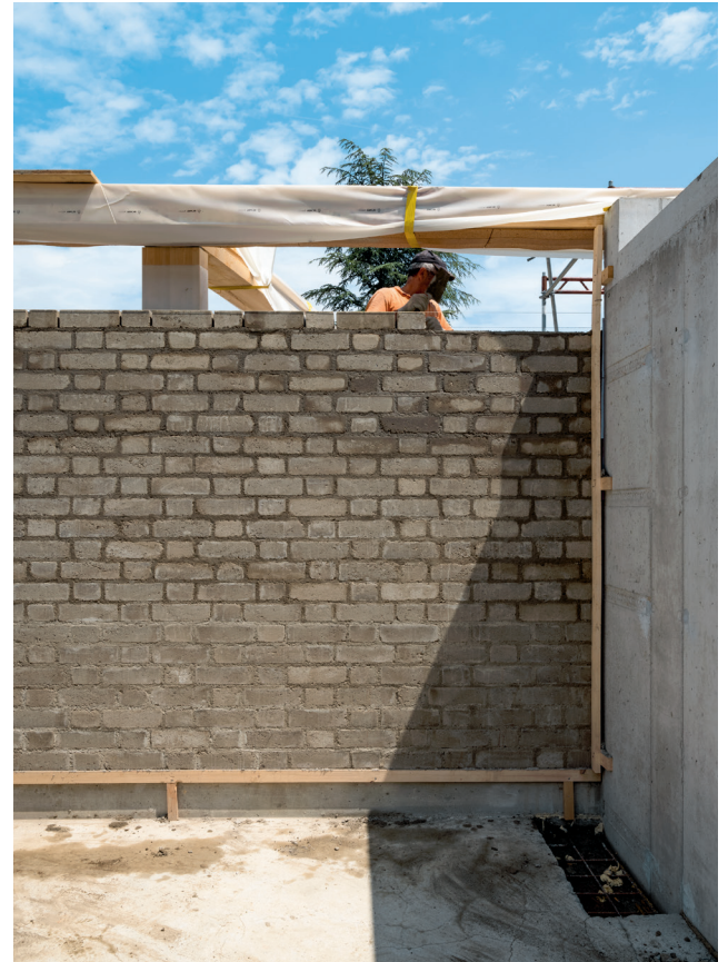
Mit rund sieben Kilo sind die Terrablocs für ihre Grösse recht schwer. Die Maurer hatten trotzdem Freude am geschlossenen Materialkreislauf.
