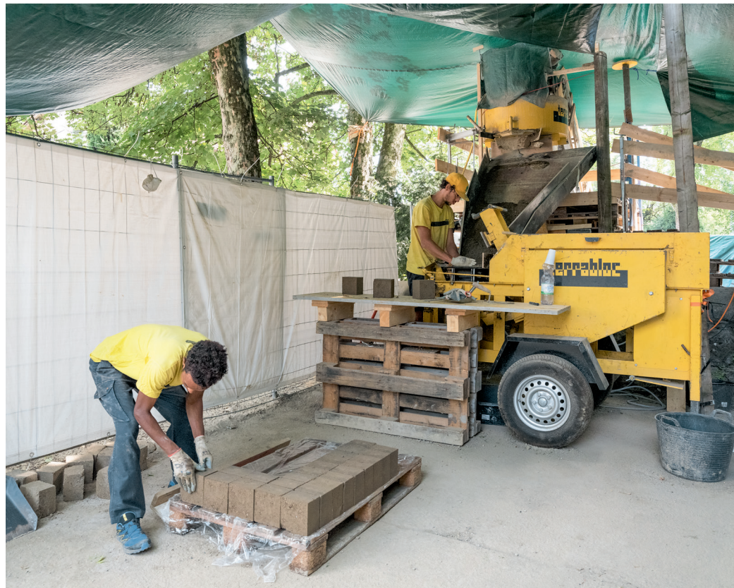
Insgesamt 22000 Ziegel wurden aus dem Aushub vor Ort gepresst, gestapelt und luftgetrocknet.
