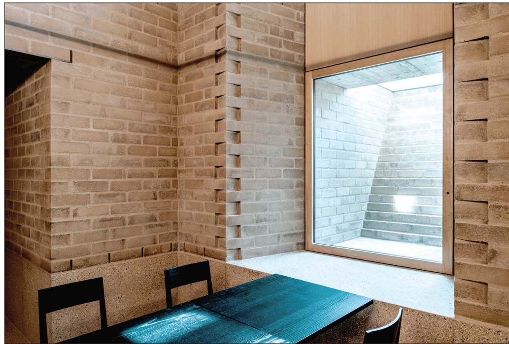
DOUBLAGE INTÉRIEUR du foyer du Grand Théâtre (maître d'ouvrage: Ville de Genève; architectes: march & linea).
