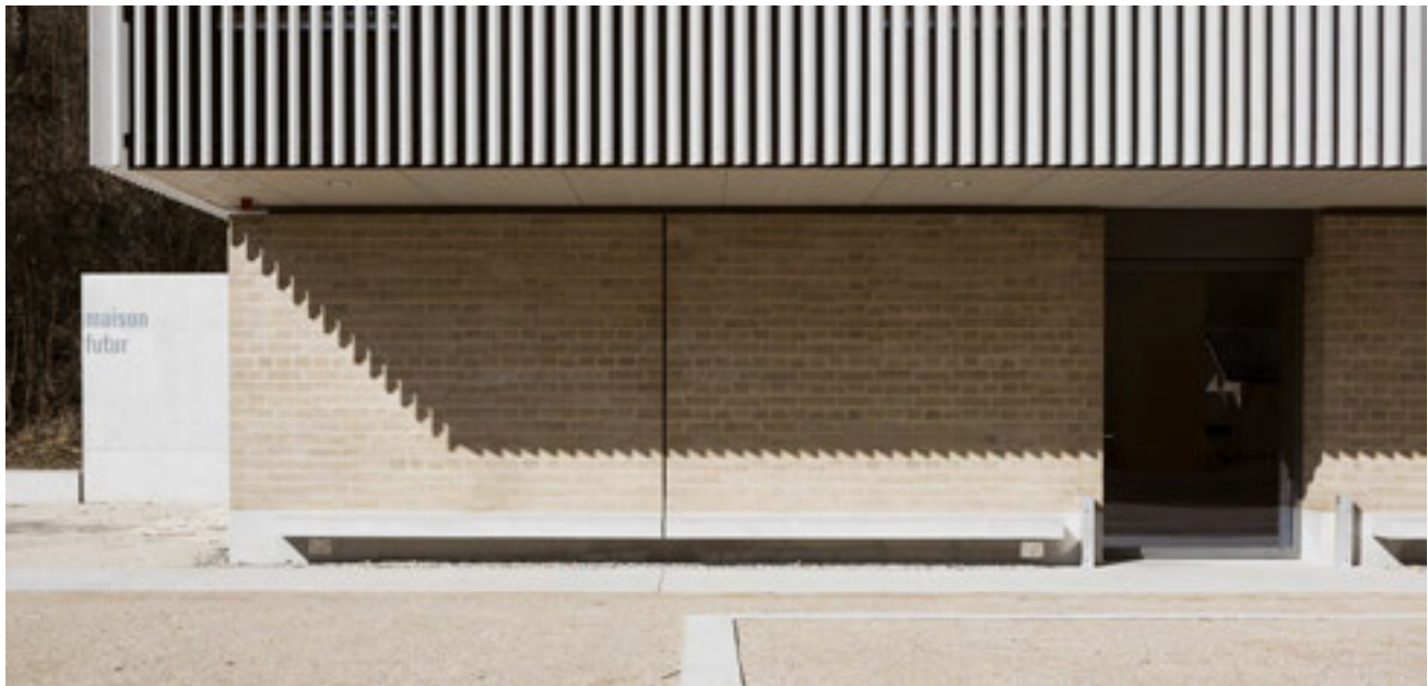
Die Verkleidungsmauer am Ausstellungspavillon La Maison du Futur der SIG in Vessy von ar-ter Architekten ist aus Lehmbausteinen.
