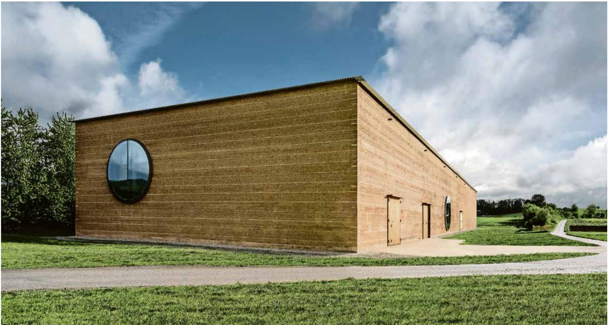
La Maison des plantes du confiseur Ricola a été réalisée par Herzog & de Meuron grâce à une technique ancestrale: une masse d'argile a été étendue couche après couche dans un coffrage avant d'être pressée et séchée. (HERZOG & DE MEURON)
